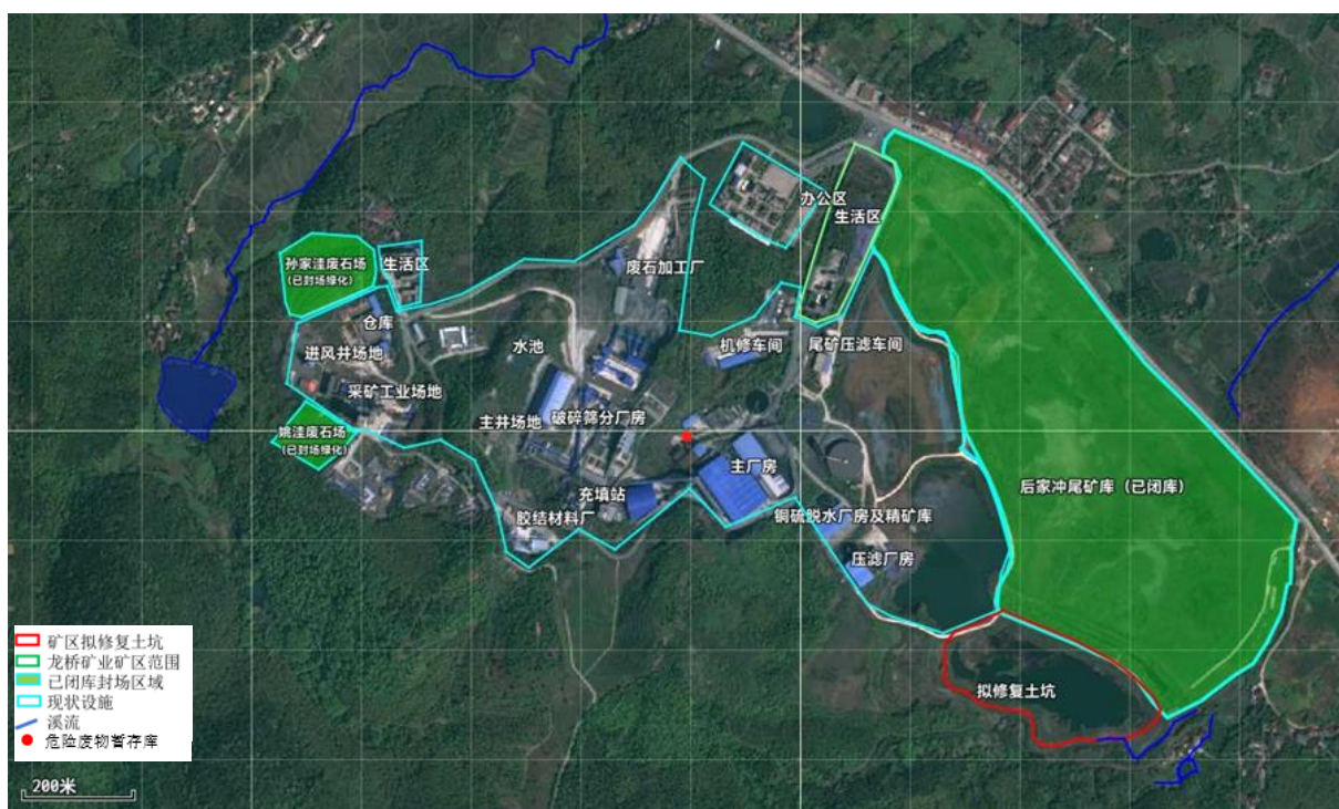
图 4.6-2 龙桥矿业危险废物暂存库位置
